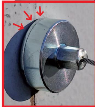
B La rondelle est encore présente, l'aimant ne tient pas, il est mal fixé !
